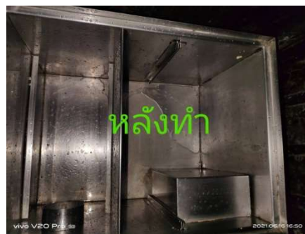
ภาพที่ 4-12 ถัดถังไขมันในห้องครัว
