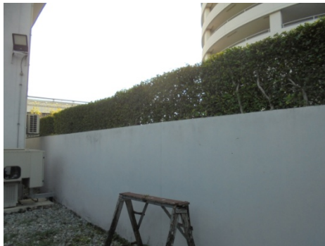
ภาพที่ 4-58 รั้วสถานไฟฟ้าย่อย สูง 2.2 เมตร และปลูกต้นไม้ยืนต้นริมรั้ว เป็นไปตามพื้นที่สีเขียวของ TERMINAL21PATTAYA
