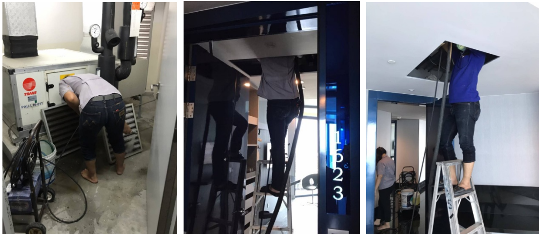
ภาพที่ 4-64 ล้างทำความสะอาดระบบปรับอากาศ
