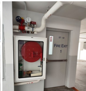
ภาพที่ 4-54 ท่อเย็นและตู้เก็บสายฉีดน้ำดับเพลิงบริเวณส่วนโรงลิฟท์ของอาคารจอดรถ Carpark
