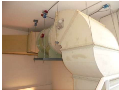
ภาพที่ 4-42 พัดลมระบายอากาศ และช่องเปิดภายในอาคาร
