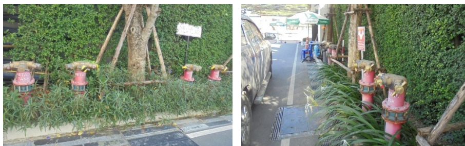
ภาพที่ 4-30 หัวรับน้ำดับเพลิงจากภายนอกส่วนโรงแรม และส่วนสรรพสินค้าพาณิชย์
