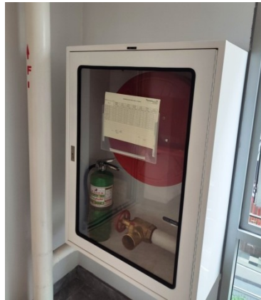
ภาพที่ 4-54 ท่อเย็นและตู้เก็บสายฉีดน้ำดับเพลิงบริเวณส่วนโรงลิฟท์ของอาคารจอดรถ Carpark
