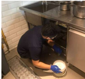
ภาพที่ 4-12 ถัดถังไขมันในห้องครัว
